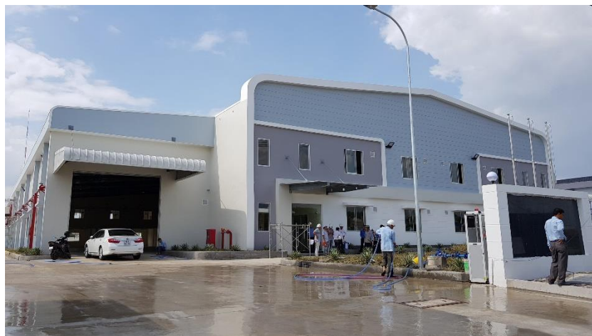
アマタシティ・ビエンホア工業団地 同タイプ建設例
