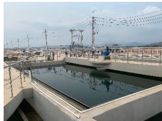
排水処理プラント（#WWTP#1） 8,000m 3 /day（Stage1）
