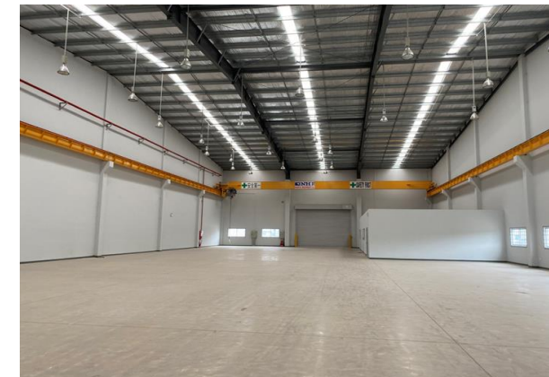
内装工事完了後
