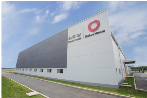
レンタル工場外観
