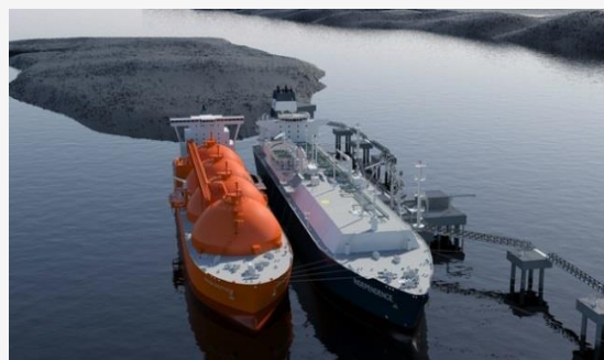
LNG受入基地
