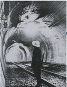
丹那トンネル
