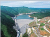
小石原川ダム
