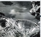
上野原ダム (日本初のアーチダム)
